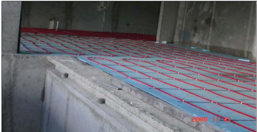
Resim 4. Kapalı Havuz Çevresi Yerden Isıtma Örneği
